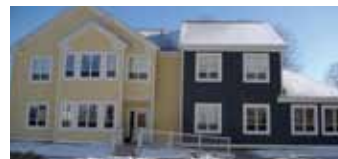
Le nouveau duplex de L'Arche Halifax
